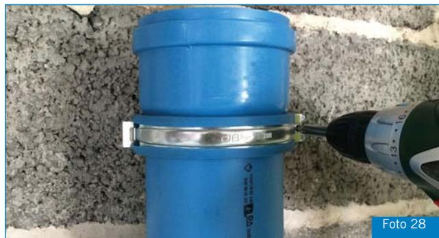
Una vez realizados los orificios (Foto 23) inserte un perno tipo Rawl en la pared y monte la abrazadera atornillando el perno a la pared en la dirección de las agujas del reloj. Al fijar la abrazadera, el tornillo se ajusta al perno tipo Rawl y, simultáneamente, la abrazadera también se ajusta hasta un tope en el tornillo de doble rosca (Fotos 24 y 25).
