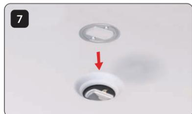
Position the metal flange onto the shower tray. Positionner la bride métallique sur le plateau de douche.
