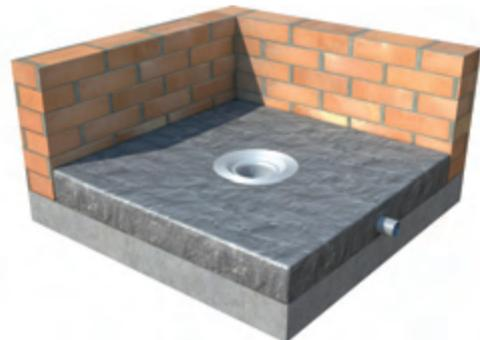
**03** Rellene con cemento toda la base del sumidero hasta el ala, proteja el sumidero evitando que caiga cemento en el interior del mismo. Dote a la base de cemento de una pendiente (recomendamos un mínimo de 2%) hacia la salida.
