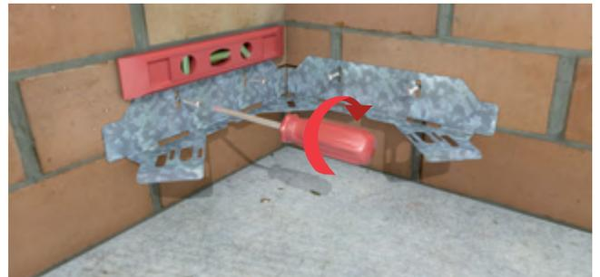
**02** Coloque el soporte a la pared para que quede perfectamente nivelado.
