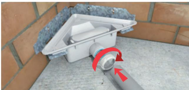
**05** Fije la tubería a la salida.
