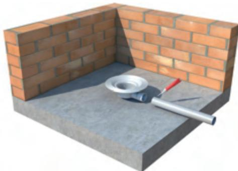
**02** Fije la tubería de PVC (previamente abocardada) al cuerpo del sumidero (para Ø40 mm es necesario cortar la salida pretrouquelada sobre la salida macho del sumidero). En primer lugar limpie la tubería y el sumidero y a continuación aplique uniformemente cola de PVC.
