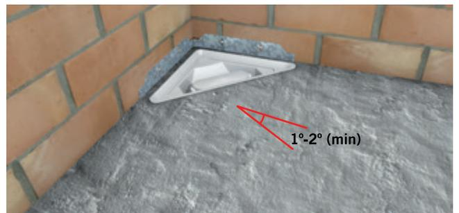
**06** Rellene con hormigón la base del cuerpo de la canaleta y el conjunto de la instalación.
