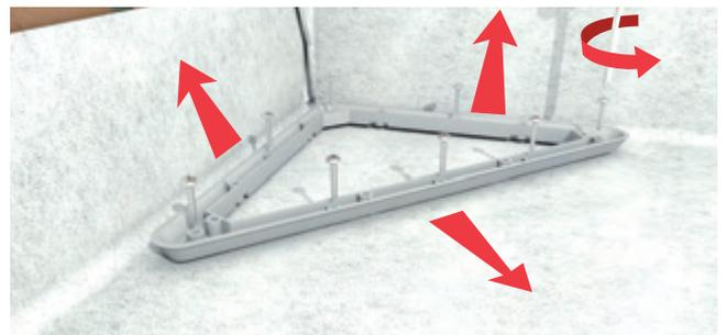
**08** Coloque la tela impermeabilizante y fíjela al cuerpo de la canaleta con los tornillos suministrados.
