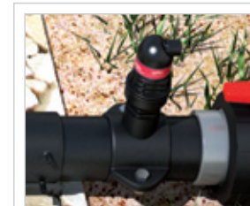
Ventosa de doble efecto gran caudal trabajando en expulsión de aire de la conducción.
