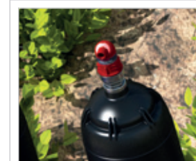
Ventosa de triple efecto trabajando en admisión y expulsión de aire y eliminando el aire residual presurizado en la red.
